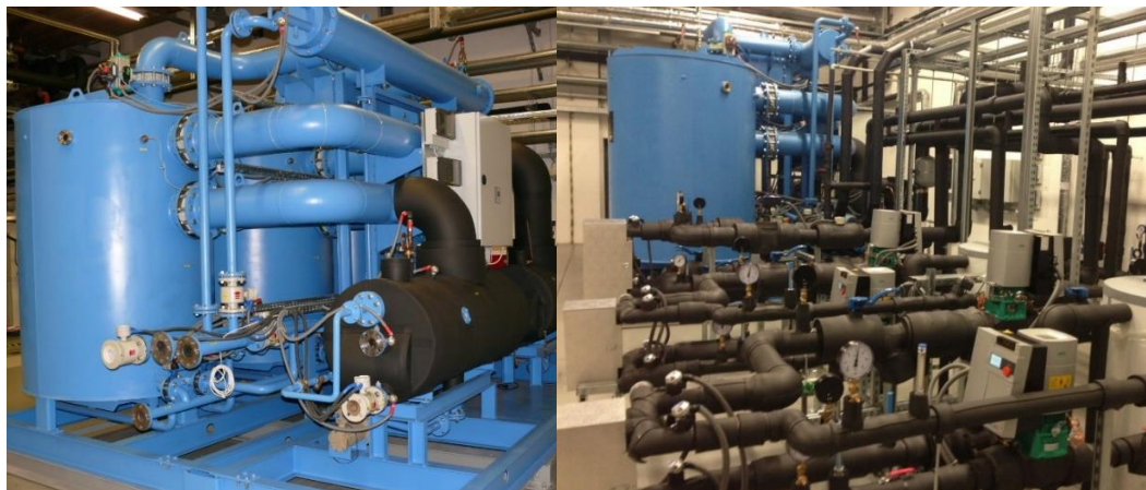
Rys. 3: Widok chłodziarki (po lewej) oraz stanowiska pomiarowego (po prawej)
